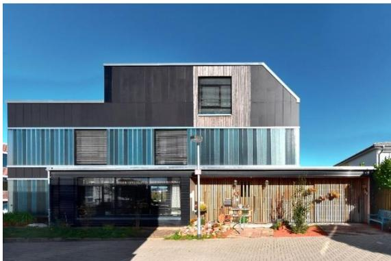
„Experiment geglückt! Das „Recyclinghaus Hannover-Kronsberg“ ist ein Prototyp, bei dem kreislaforientierte und ressourcenschonende Planung umgesetzt wurde. Recyclingbeton, gebrauchte Bauteile, Jutedämmung aus Kakaobohnensäcken – wo immer möglich, setzten Bauherrin und Architekturbüro auf die
